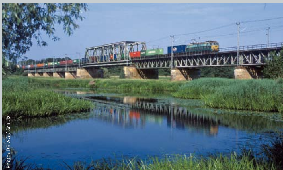
Container block train on the Oder Bridge, the border-crossing point in Frankfurt an der Oder
