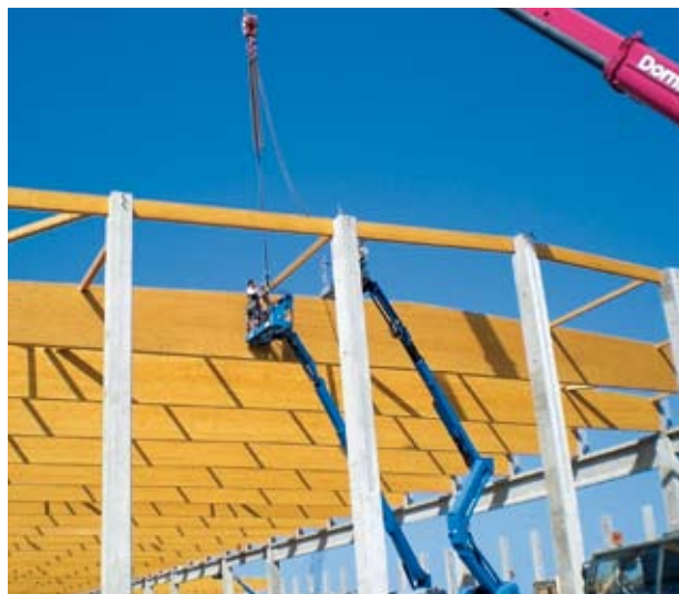
Die bis zu 60 Meter langen Holzleimbinder werden für den Bau von Hallen eines Spanplattenwerkes in Rumänien eingesetzt
