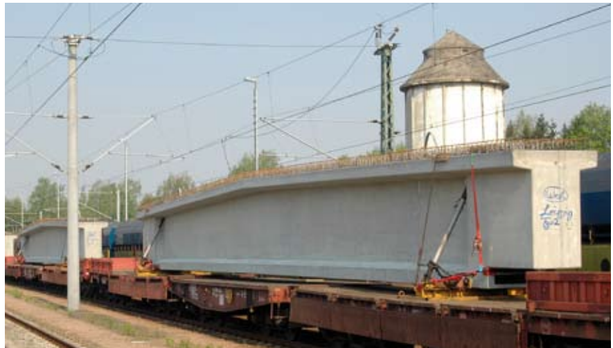
Aufgrund ihrer Länge von 26 Metern müssen die 93 Tonnen schweren Betonträger auf jeweils drei Wagen transportiert werden
